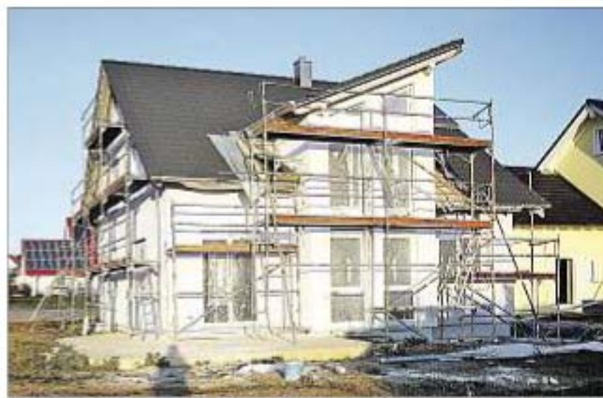
Das Einfamilienhaus hat nicht nur ein Satteldach: Die beiden Querbauten wurden mit Pultdächern bestückt.
