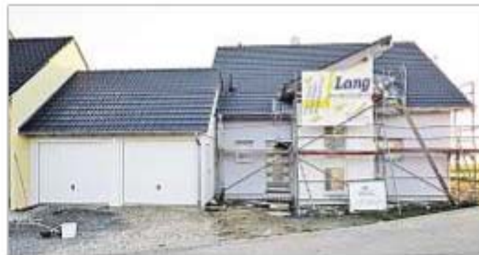
Linkerhand des modernen Gebäudes wurde eine Doppelgarage angeordnet. (Fotos: Rathgeb)
