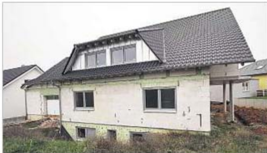
Auf der rückwärtigen Seite des Gebäudes wurde in das Satteldach eine Schleppgaube integriert. (Fotos: Rathgeb)
